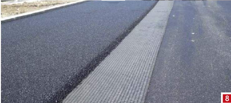
6. Układanie asfaltu na drodze w XIX w.; 7. Rodzaj mieszanki betonowo-asfaltowej; 8. Współczesna warstwa geotótkinowa; 9. Jeden z typów geokrat nawierzchniowych
