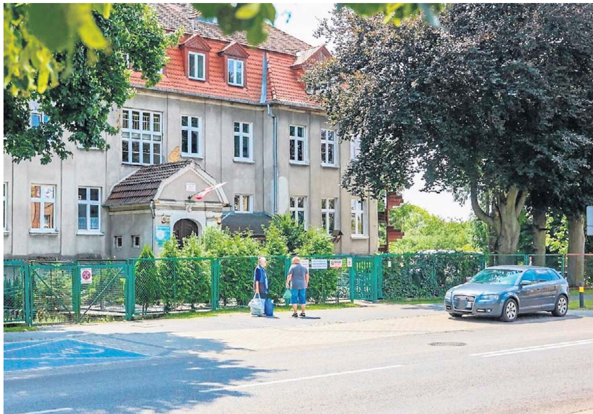
Przedszkole jest w opłakanym stanie. Budynek przejdzie remont
