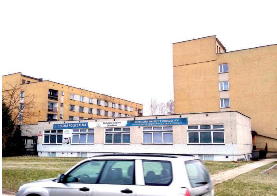
Po modernizacji obiektu przy Okopowej mogą bialskiemu Starostwu Powiatowemu dać możliwość zyskania siedziby dla instytucji powiatowych
