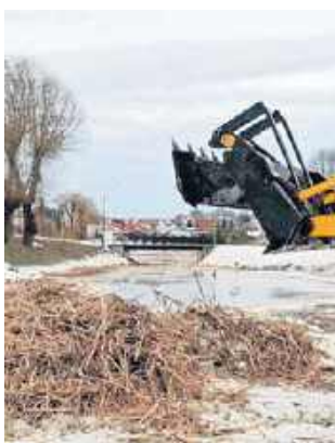
Zbiornik i jego brzegi oczyszczono z roślinności
