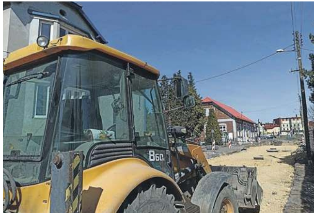
Ulica Ochronkowa rozkopana - trwają roboty drogowe
