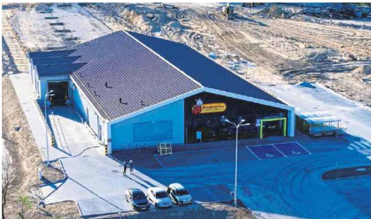
Wszystko wokół nowego sklepu Biedronka w Pińczowie jest już niemal gotowe
