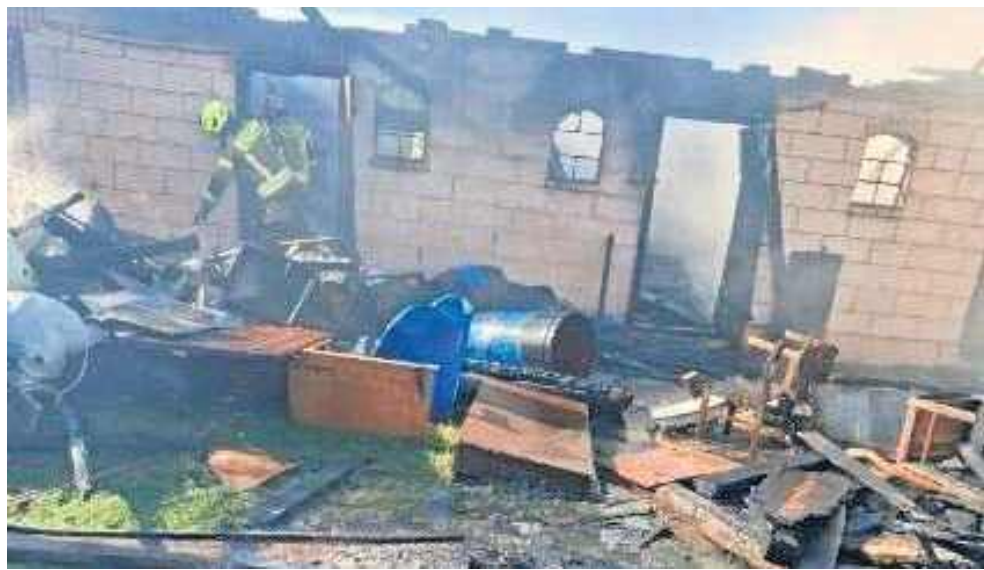
Pożar budynku gospodarczego w Kociołkach w gminie Koźienice.
