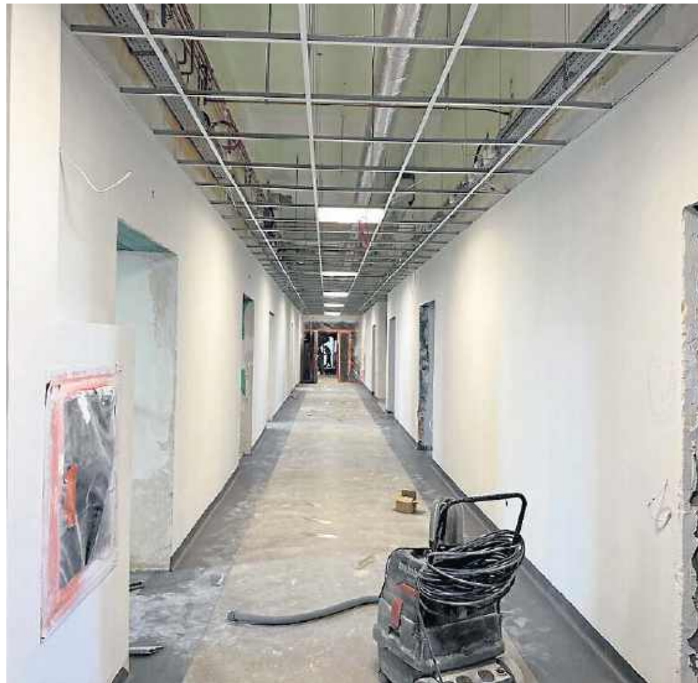
Trwa rozbudowa Zakładu Opiekuńczo-Leczniczego w Opatowie
