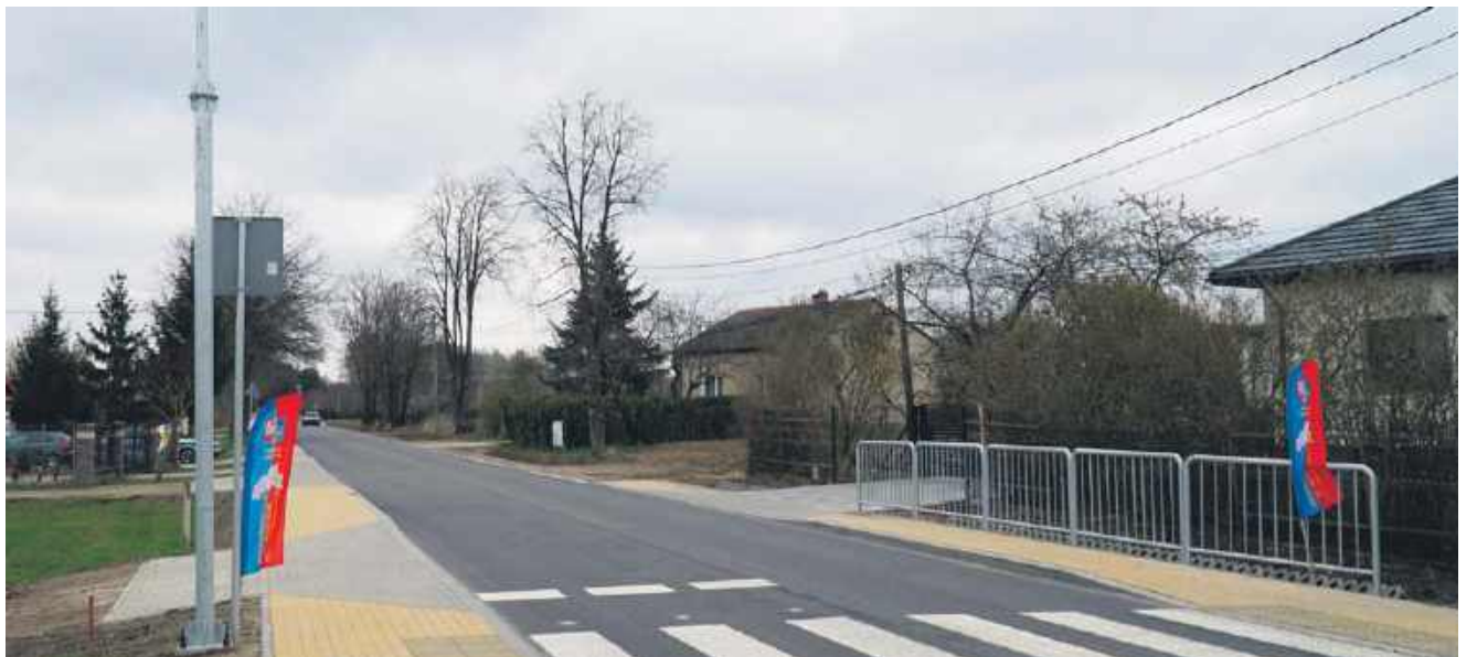
Zmodernizowana droga powiatowa nr 4512W Zwoleń – Tczów w miejscowości Mostki.
