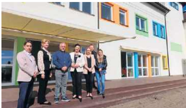
W Piekoszowie powstało nowoczesne skrzydło budynku, usytuowane prostopadle do ulicy Czarnowskiej
