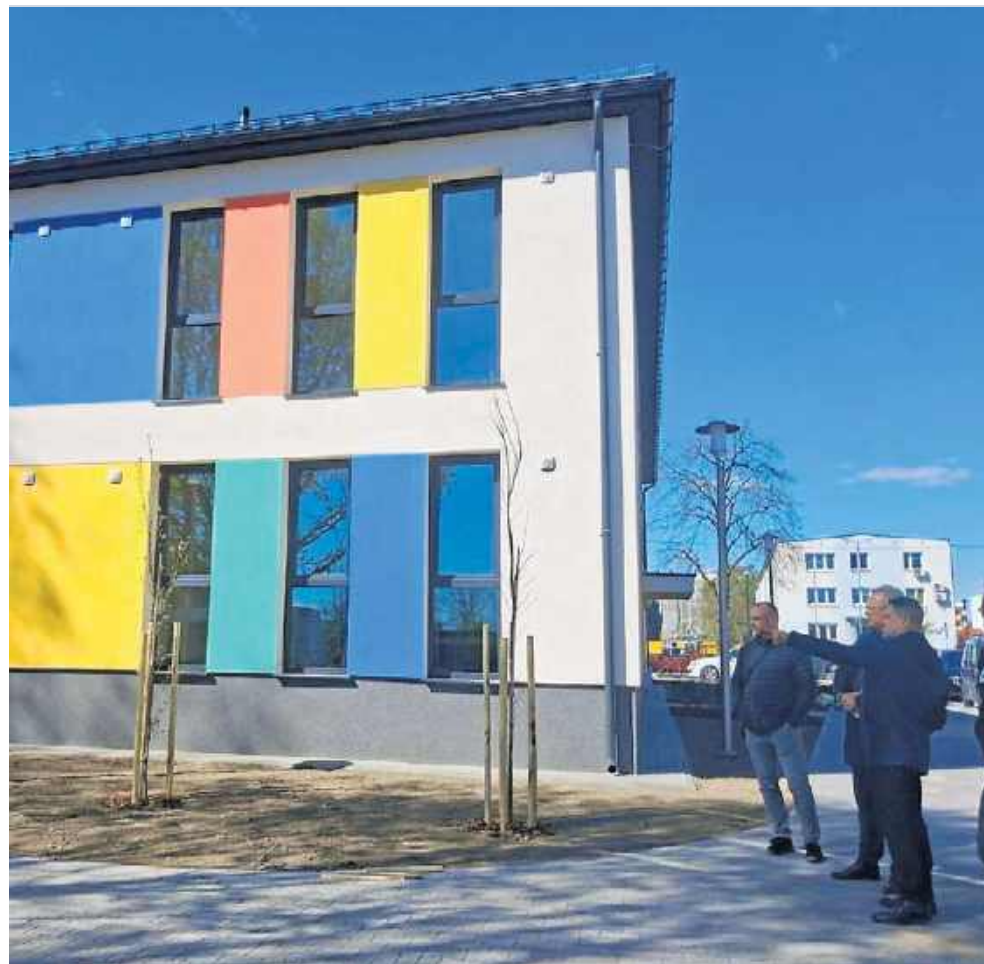
Wizyta na budowie żłobka
