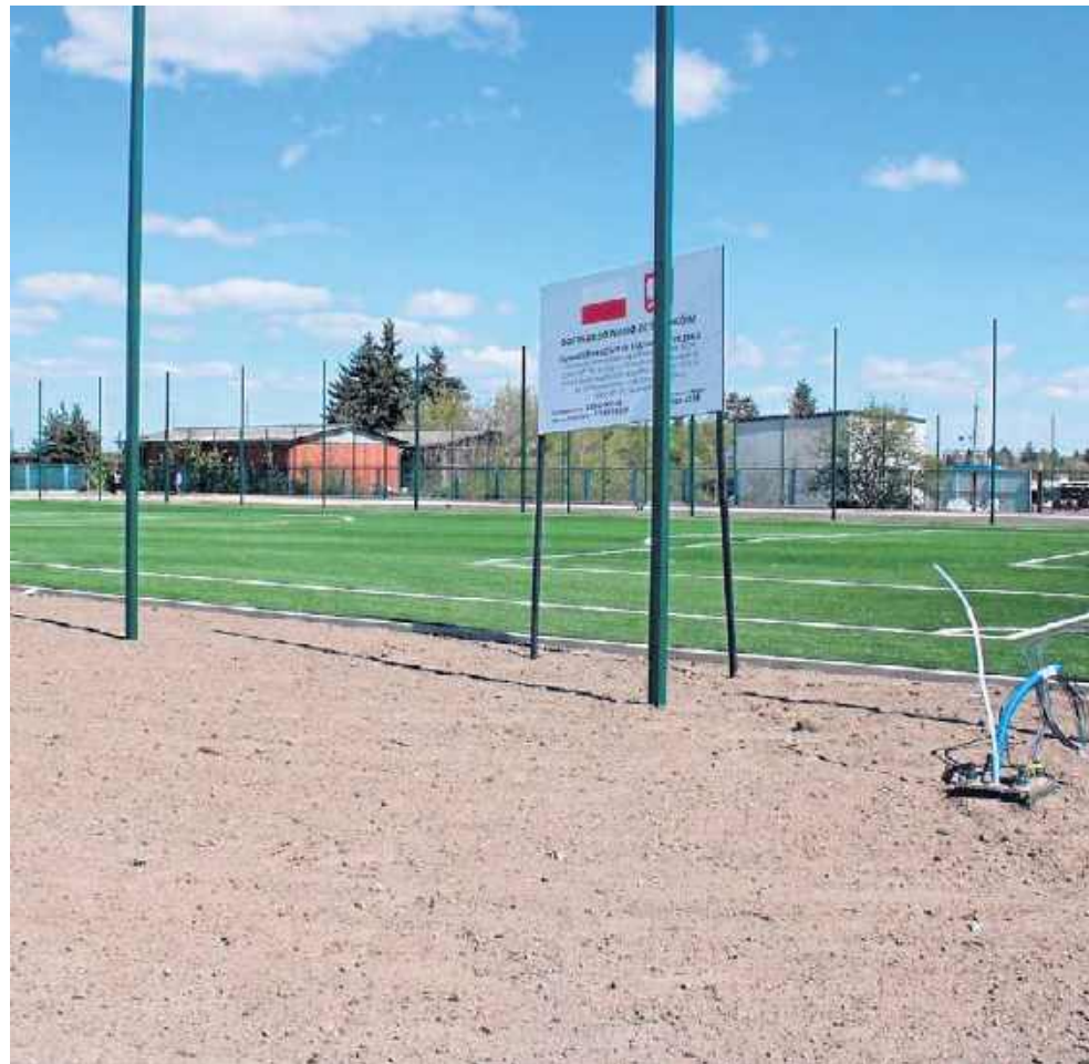
Na tyłach szkoły przy ulicy Wierzbickiej budowany jest największy Orlik w mieście.
