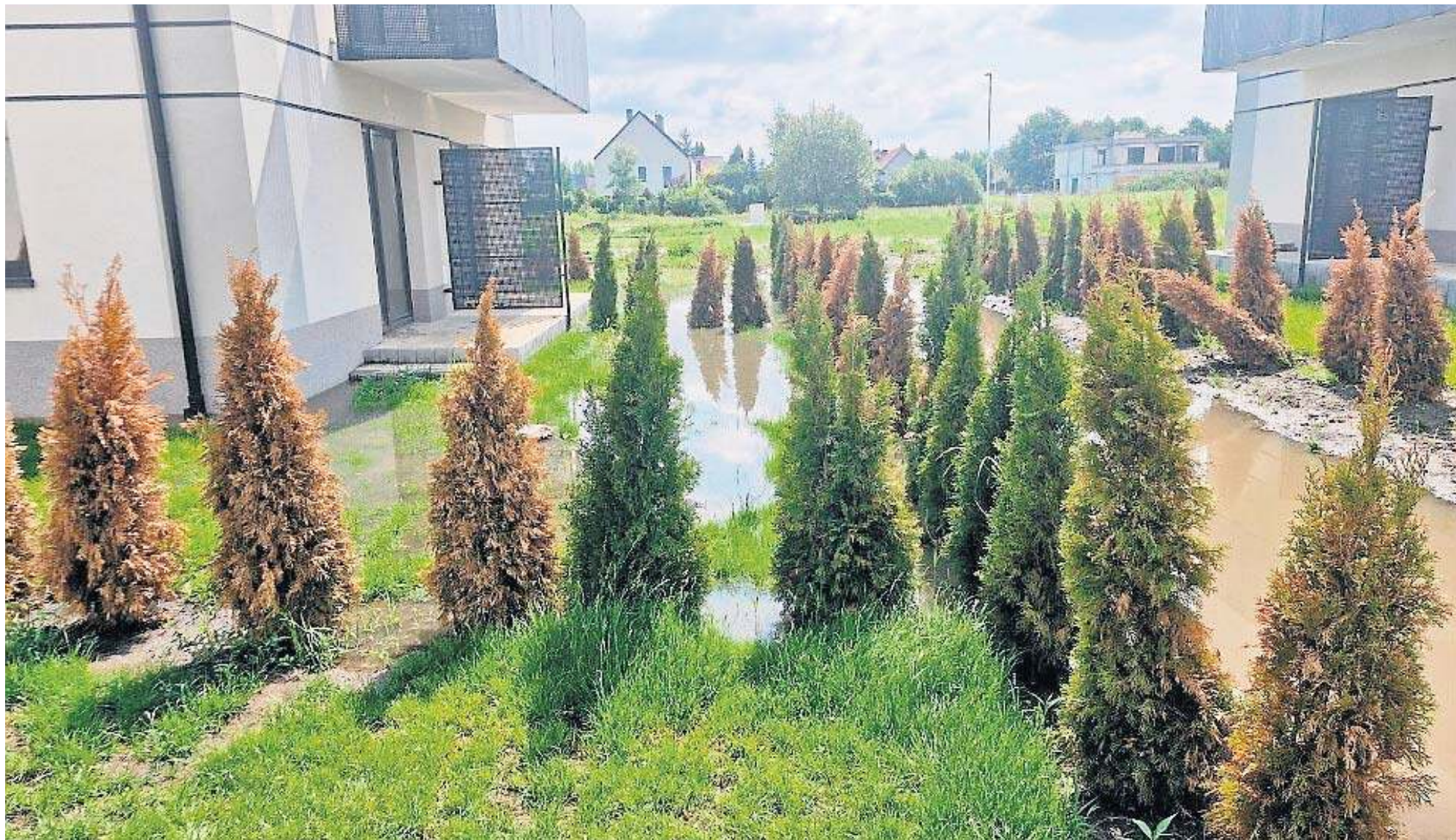
– Po opadach całe osiedle tonie. Wody gruntowe są na tyle płytko, że fundamenty nasiąkają wodą – skarżą się nam Czytelnicy
