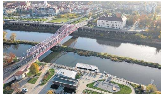
Remont dotyczy dylatacji, które są już stare i trzeba je wymienić, żeby było bezpiecznie
