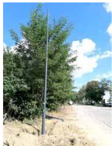
Na ulicy Śniadeckiego trwa montaż nowych lamp
