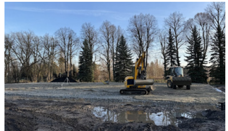
Trwają intensywne prace przy budowie boiska wielofunkcyjnego zlokalizowanego przy Zespole Szkolno-Przedszkolnym nr 2 w Brzegu Dolnym. Inwestycja została podzielona na dwa etapy, a jej finał zaplanowano na 15 czerwca 2026 roku. W tym roku wykonano pierwszy etap pracy tzn. roboty ziemne i warstwy stanowiące podbudowę pod nawierzchnię boiska robót ziemnych. W przyszłym roku rozpocznie się drugi etap, obejmujący montaż głównych elementów, oświetlenia, trybun oraz siłowni plenerowej. Całkowita wartość umowy wynosi 1 097 000,00 zł brutto. Projekt opiera się na montażu finansowym: po 30 procent kwoty pochodzi z Urzędu Marszałkowskiego Województwa Dolnośląskiego oraz Ministerstwa Sportu i Turystyki, natomiast pozostałe 40 procent zabezpieczyła Gmina Brzeg Dolny.
