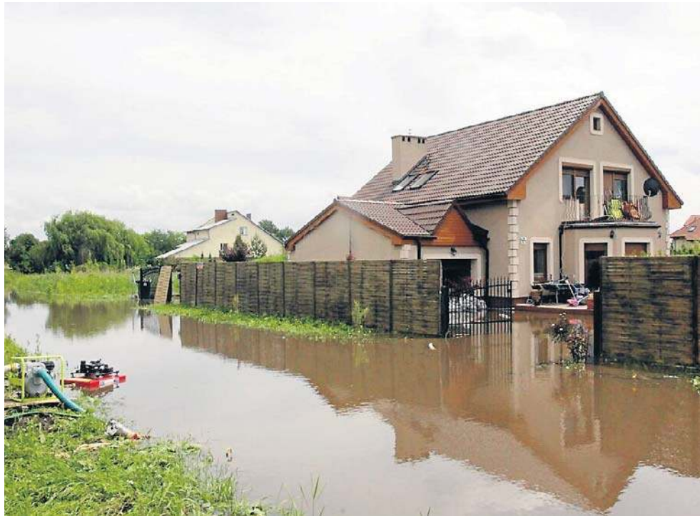
Wystarczy oberwanie chmury, żeby dom został zalany. Powodzie w Polsce zdarzają się coraz częściej i powodują duże straty. Ograniczy je odpowiednie ubezpieczenie
