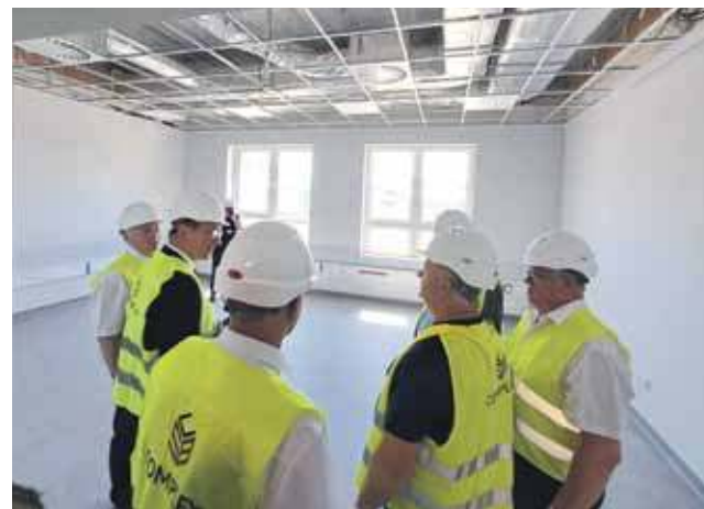
Po zachwytach na sali obrad i wspólnej fotografii z czekami na schodach - przyszedł czas na wizytę w budowanej szkole.
