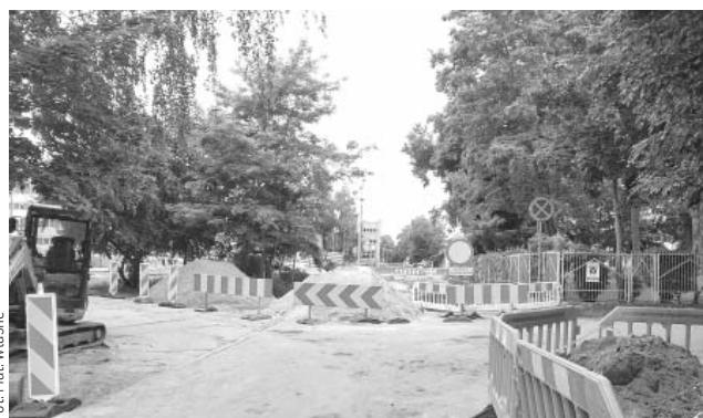
Budowa nowego skrzyżowania w Olsztynie
