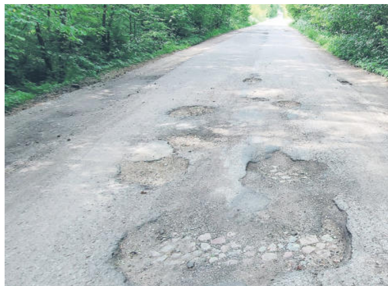
Powiatowa droga z Ceranowa do Ryteł
