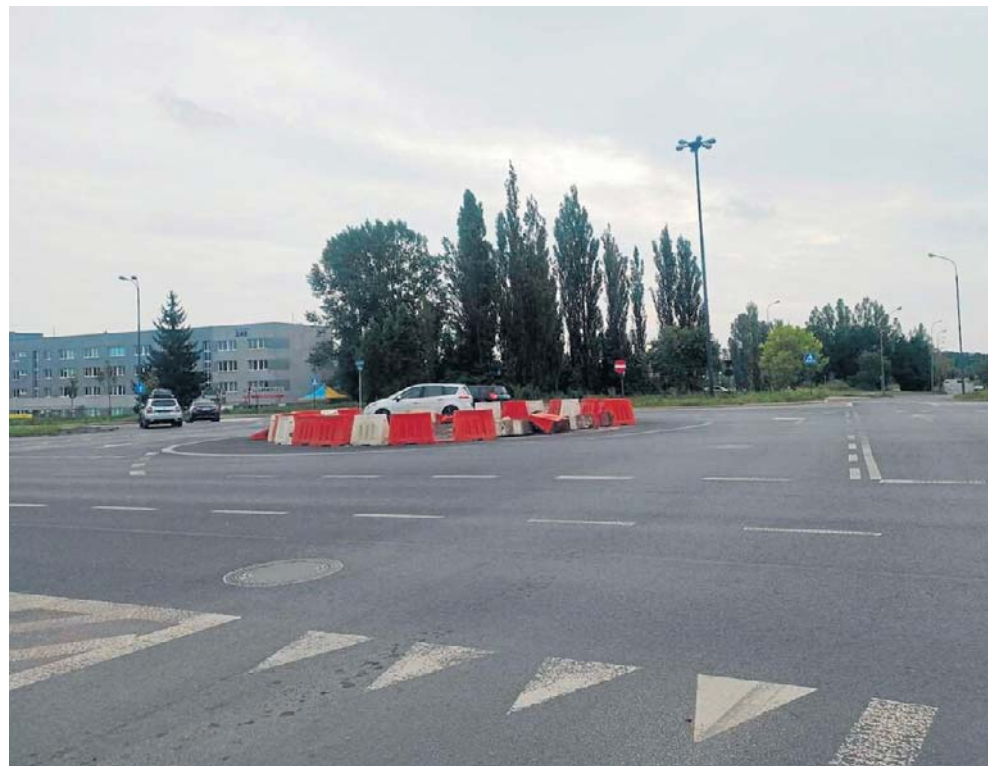
Skrzyżowanie ul. Dąbrowskiego i Lodowej ma zostać przebudowane na rondo turbinowe. Ma to pomóc w ograniczeniu liczby kolizji i wymuszeń pierwszeństwa
