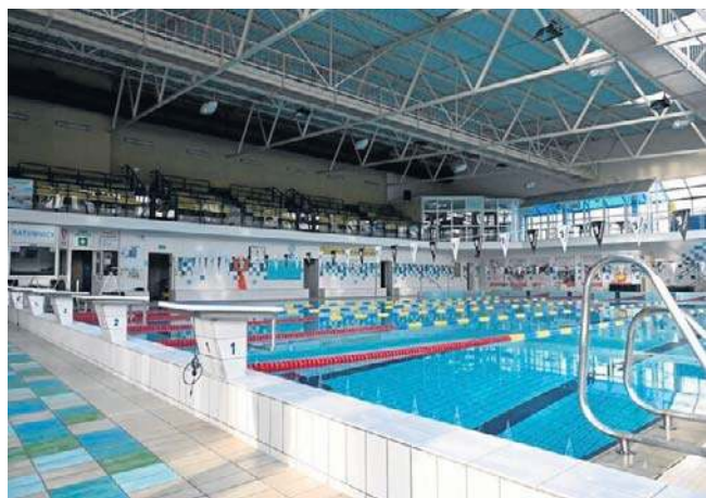
Basen już otwarty. Podczas remontu przeprowadzono m.in. wymianę instalacji uzdatniania wody
