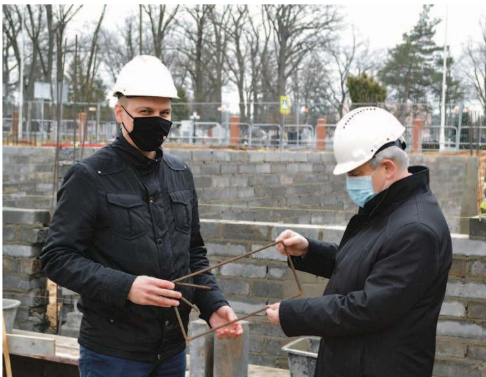
Wiceminister (z lewej) zapoznał się m.in. ze stanem zaawansowania robót na budowie nowej remizy dla rudnickich strażaków
