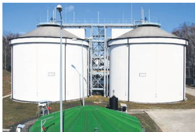
Przebudowa oczyszczalni to koszt ponad 58 mln zł.
