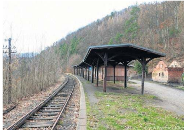
Pilchowice-Zapora. Nieczynny przystanek na trasie Jelenia Góra-Lwówek Śląski za parę lat ma znów ożyć
