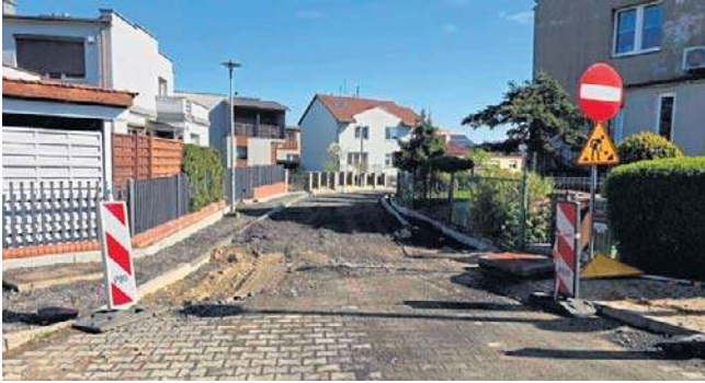
Prace są zaawansowane. W pierwszej kolejności roboty objęły ulice Kochanowskiego i Asnyka
