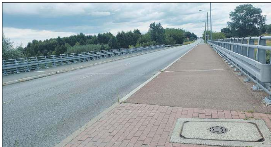
W ramach inwestycji przebudowana zostanie Al. Solidarności na całej długości
