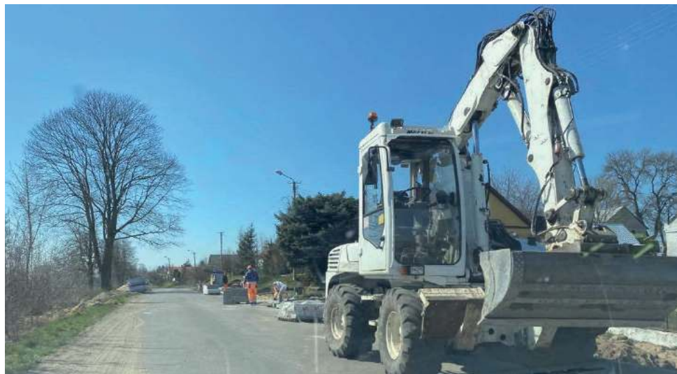
Prace postępują sprawnie. Sprzęt i robotnicy znikną z trasy prawdopodobnie już w czerwcu
