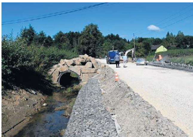
Przebudowa drogi powiatowej w Olchawie. W trakcie prac zostaną też umocnione skarpy potoku
