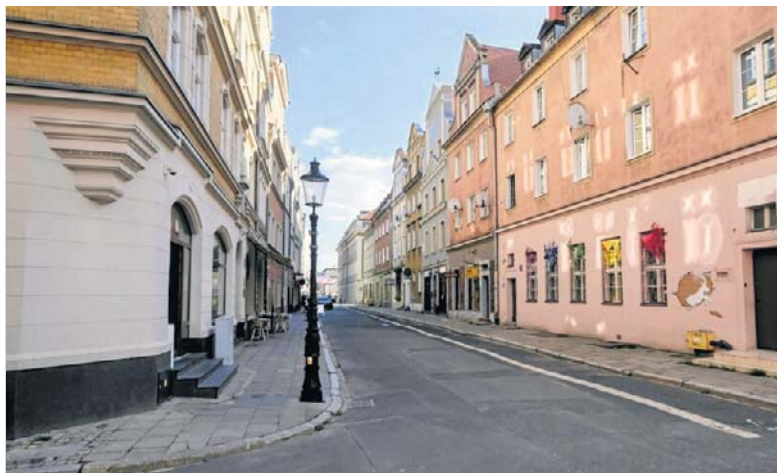
Ulica Wroniecka jedyna na liście do remontu. Ale harmonogramu brak
