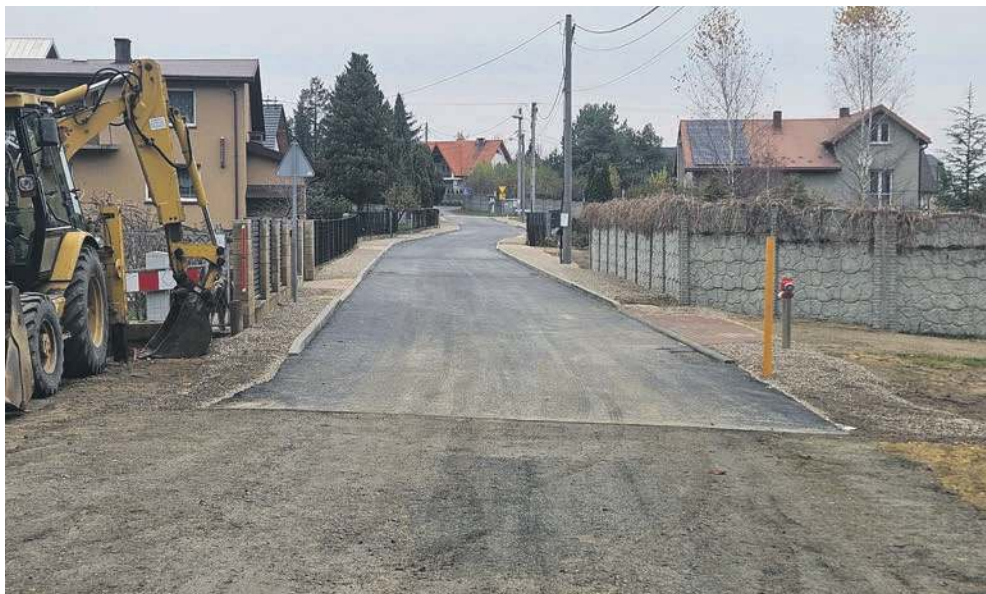
Ulica Robotnicza w Sierszy po zakończeniu prac
