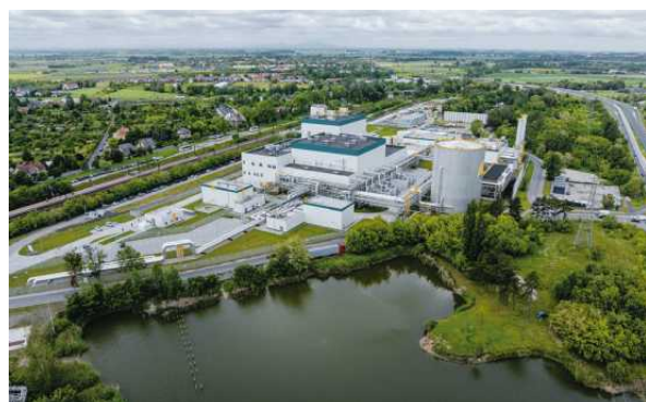
Elektrociepłownia gazowa Czechnica-2 w Siechnicach
