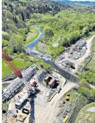
Prace przy budowie mostu kolejowego nad Mszanką
