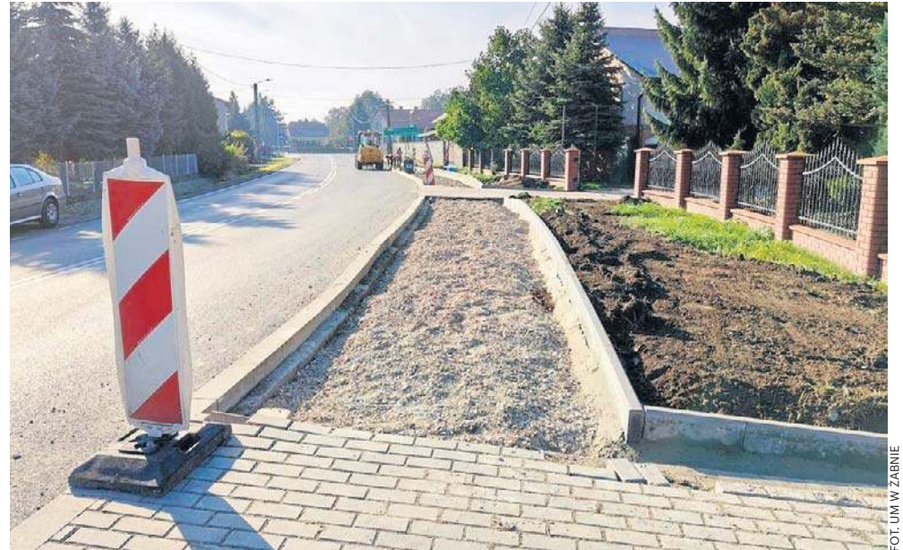
Prace przy budowie brakujących odcinków chodnika przy DW 973 są już mocno zaawansowane
