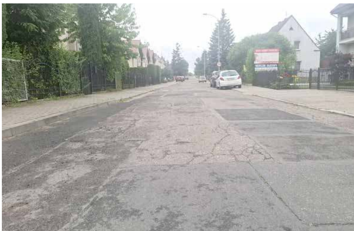
Miasto informuje, że dokonało prac remontowych na drodze wzdłuż ul. Szymanowskiego
