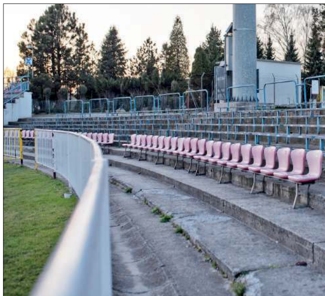
Na Stadionie Miejskim demontowane są krzeselka w sektorze „O” w celu naprawy i konserwacji konstrukcji stalowych
