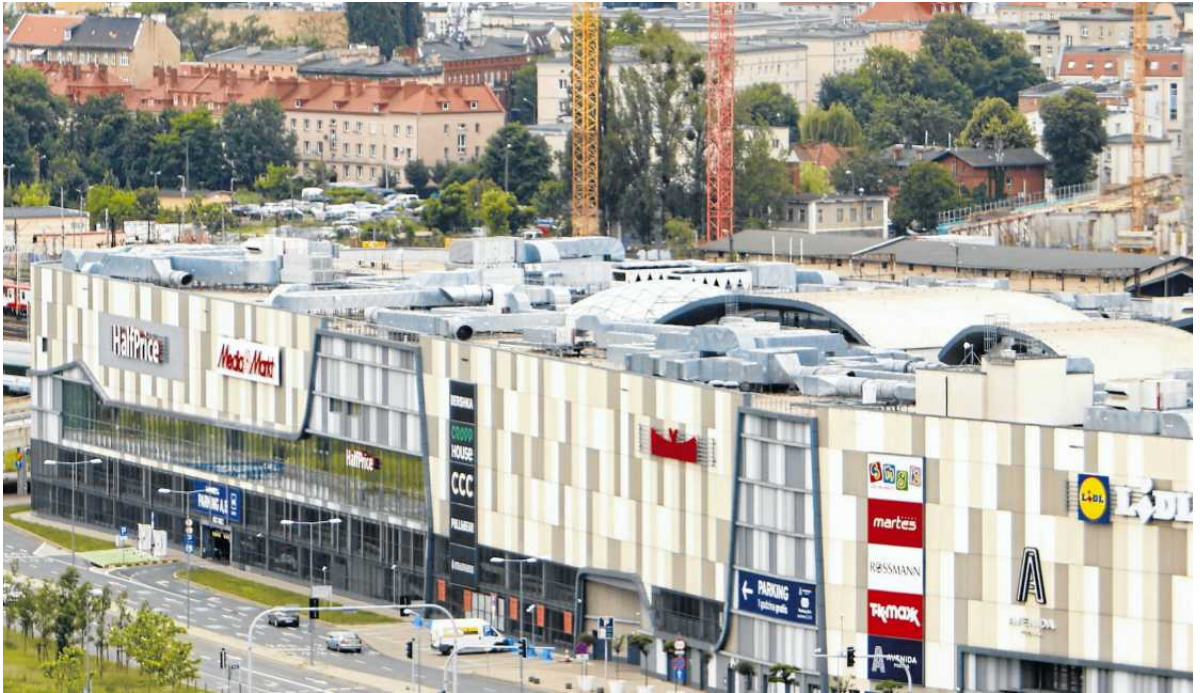
• Galeria Avenida Poznań Główny. W sklepie H&M runął fragment sufitu FOT. PIOTR SKÓRNICKI / AGENCJA WYBORCZA.PL
