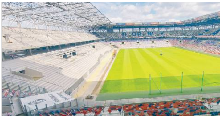
Tymczasem budowa czwartej trybuny postępuje! W tym tygodniu montowane jest m.in. poszycie dachu.
