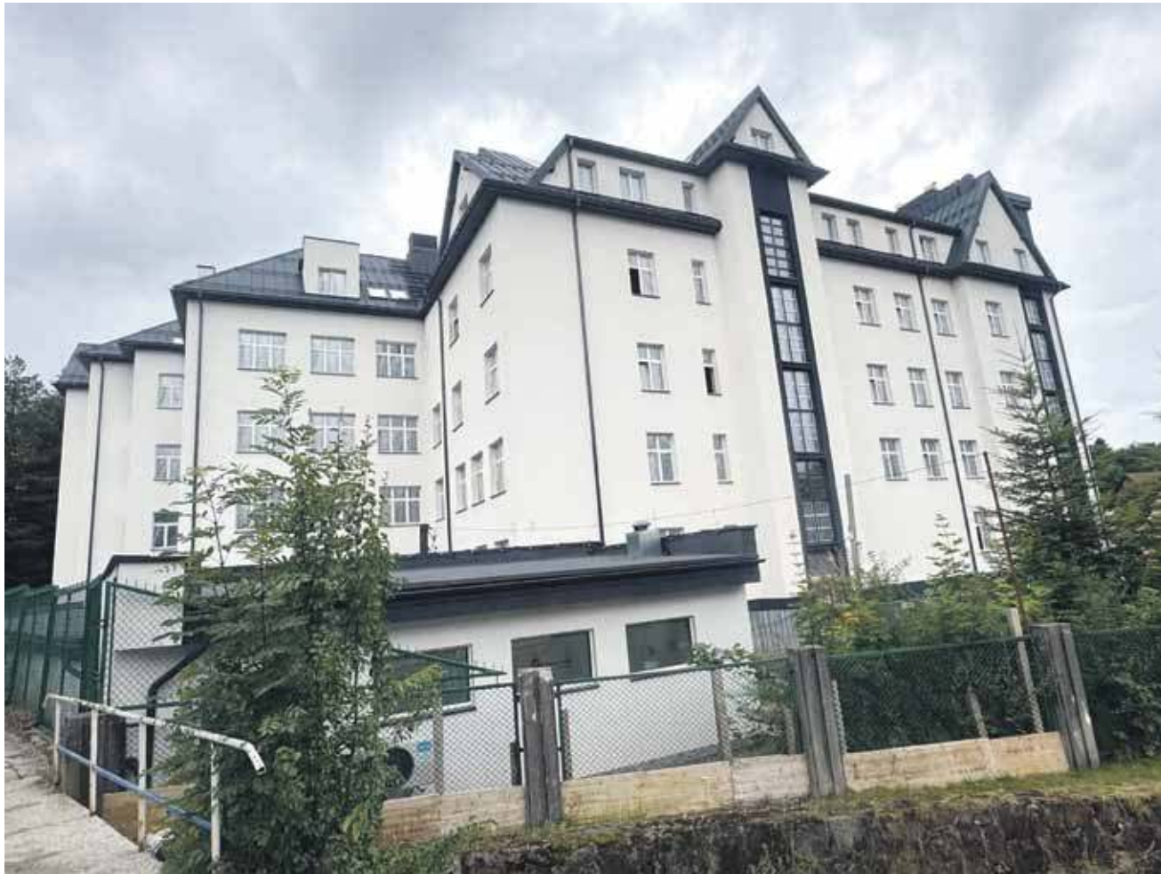
Budowa nowego gmachu rabczańskiego szpitala dobiega końca.
