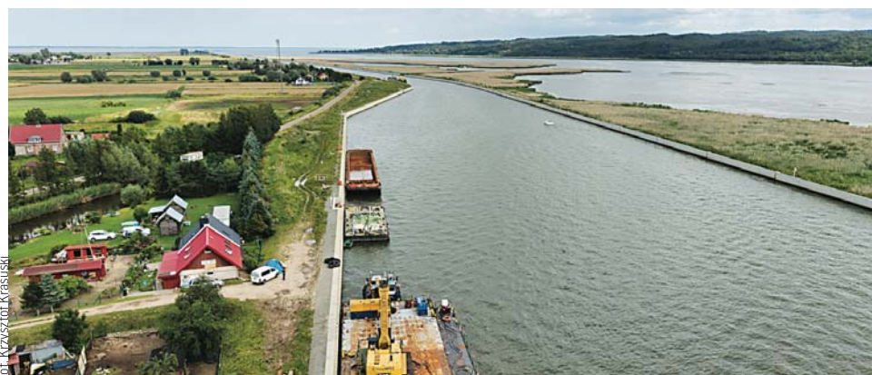
Obecnie prace pogłębiarskie prowadzone są na odcinku rzeki Elbląg o długości 7,45 kilometra, od Zalewu Wiślanego do punktu P1 w rejonie oczyszczalni ścieków
