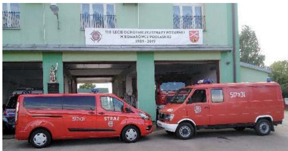
Prace termomodernizacyjne remizy rozpoczęły się 18 lutego. Koniec remontu jest zaplanowany na 30 października tego roku
