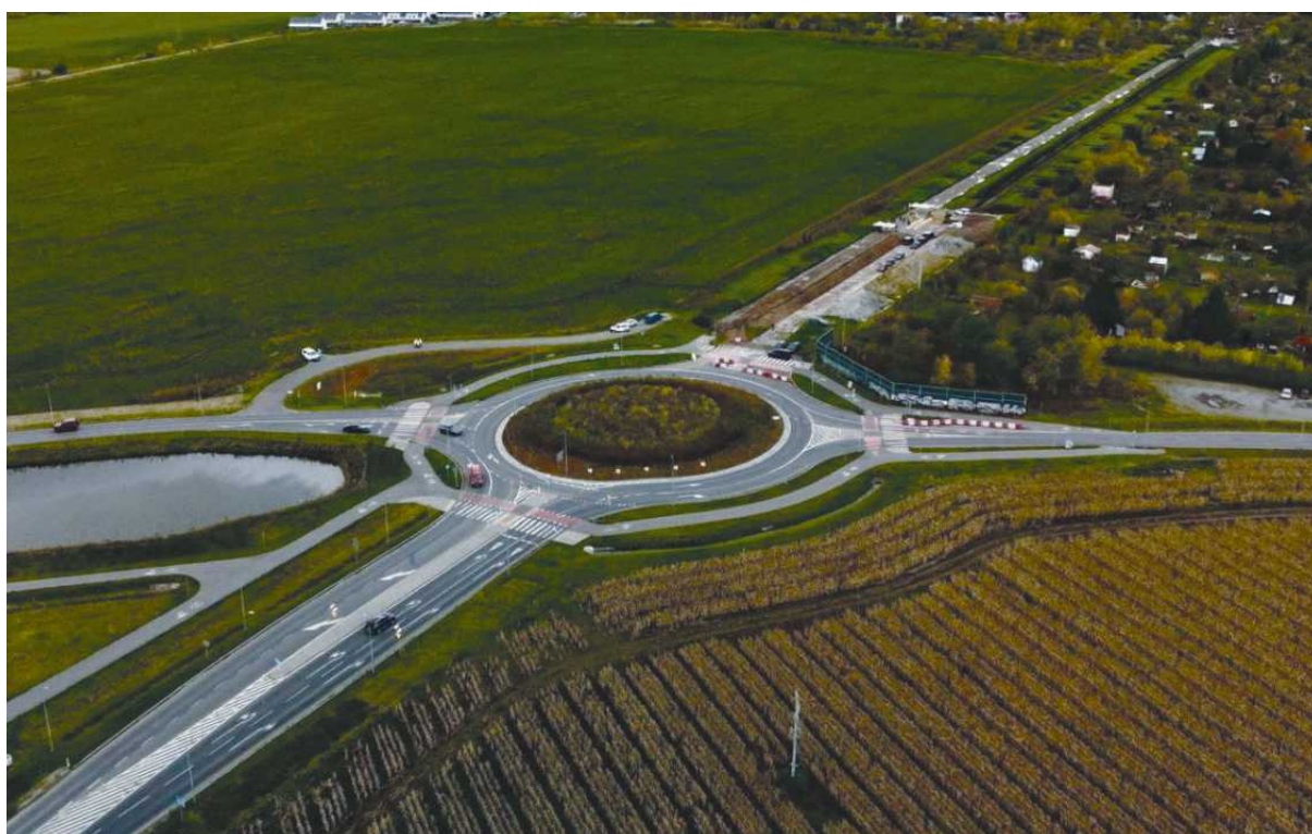
Budowa ostatniego odcinka Wschodniej Obwodnicy Wrocławia fot. Materiały prasowe UMWD
