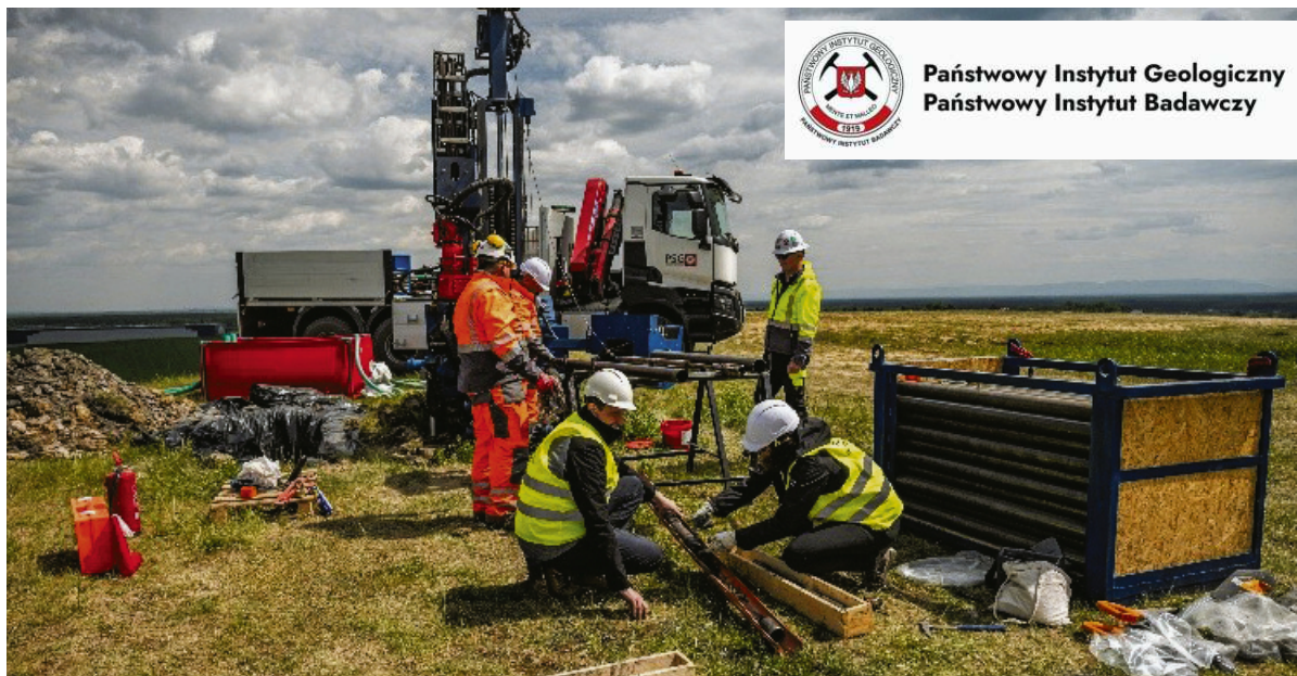
Wiercenie badawcze PIG-PIB na hałdzie powęglowej Marta Waleska na Górnym Śląsku.
