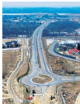
Trwa budowa południowej obwodnicy Oświęcimia
