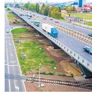
Modernizacja estakady będzie trwała 4 miesiące
