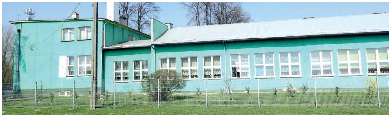
Budynek szkoły w Uhninie
