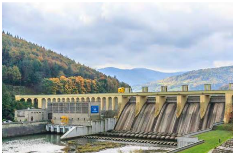
Zapora wodna na Sole w Międzybrodziu Bialskim, elektrownia „Porąbka”. Foto – Adobe Stock
