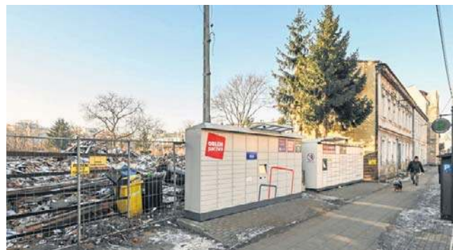
Na ul. Dolina zniknęła kamienica, a druga czeka na rozbiórkę
