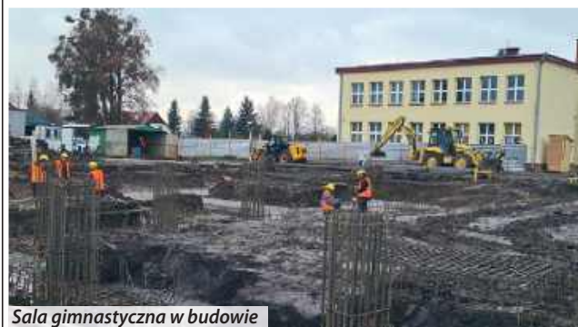
Sala gimnastyczna w budowie
