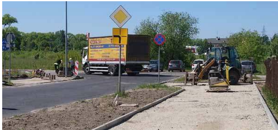
Wykonano już warstwy konstrukcyjne pod zaprojektowane nawierzchnie
