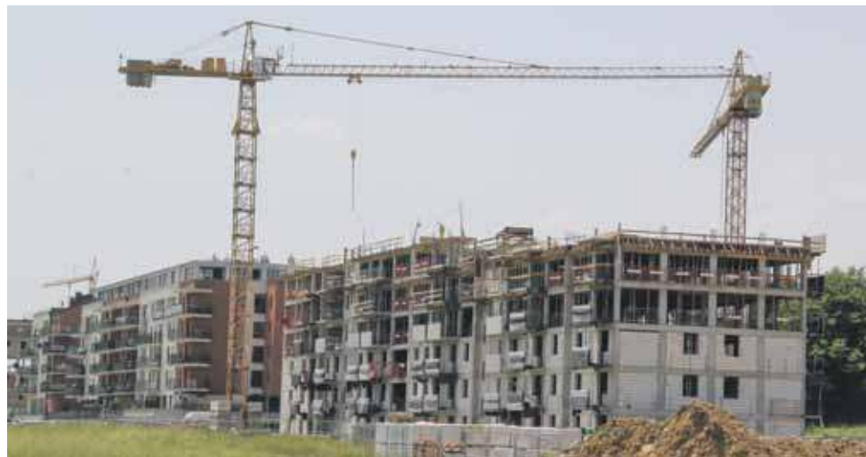
Ceny najmu mieszkań w budowanym w ramach programu Mieszkanie + bloku, będą znane dopiero jesienią.
