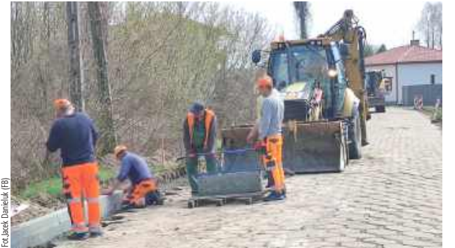
Najpierw na ul. Popiełuszki rozpoczęto oczyszczanie istniejącej nawierzchni z trylinki i układanie krawężników betonowych
