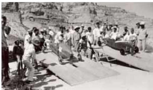
Na zdjęciu z 1939 pokazane jest jedno z rozwiązań ramp startowych z ogranicznikiem kołkowym, zwalnianym za pomocą ręcznej dźwigni (fot. https://tiny.pl/h4hy0b7w )
