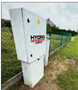
Przepompownię ścieków zmodernizowano m.in. w Kamieniu Śląskim.
