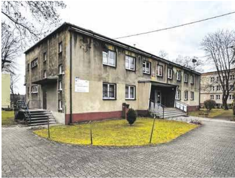
Termomodernizacja poprawi także estetykę budynków przedszkolnych
