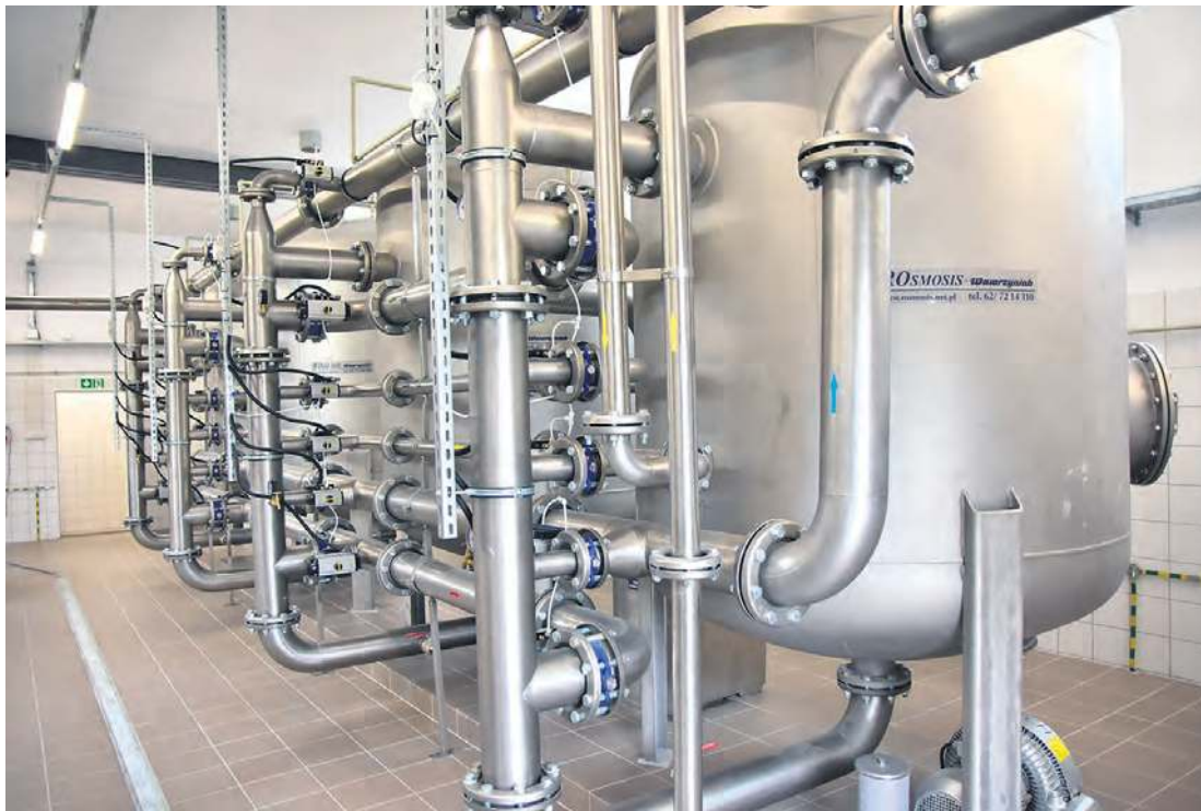
W Bystawiu minął miesiąc od otwarcia przebudowanej hydroforni, ale cały czas nie zlecono tam nowych badań wody. Tymczasem gmina wyłoniła wykonawcę prac w lubiewskiej stacji. Będzie nim ta sama firma, która przeprowadziła remont w Bystawiu: Rosmosis – Wawrzyniak Group.
