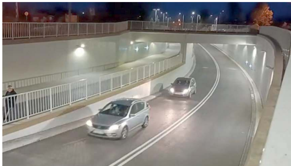
Kierowcy mogą już korzystać z tunelu kolejowego przy ul. Lubelskiej
