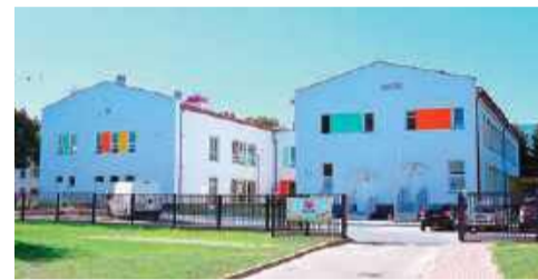
Zmodernizowane przedszkole z dobudowanym skrzydłem
