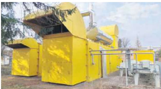
W modernizację sieci ciepłowniczej trzeba zainwestować co najmniej 5 mln zł.
