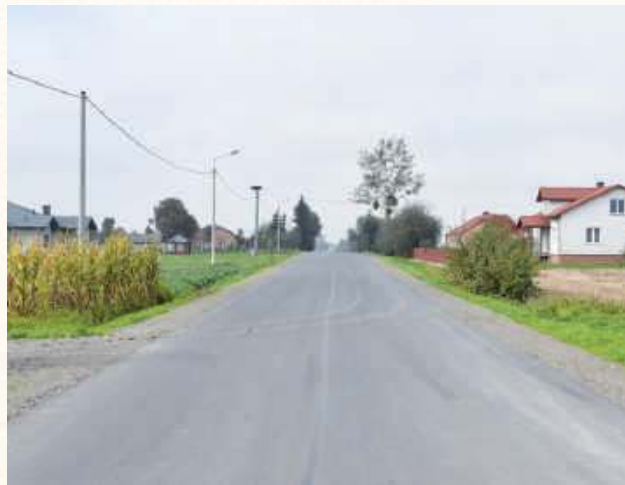
Przebudowana droga w Brodniczy.
